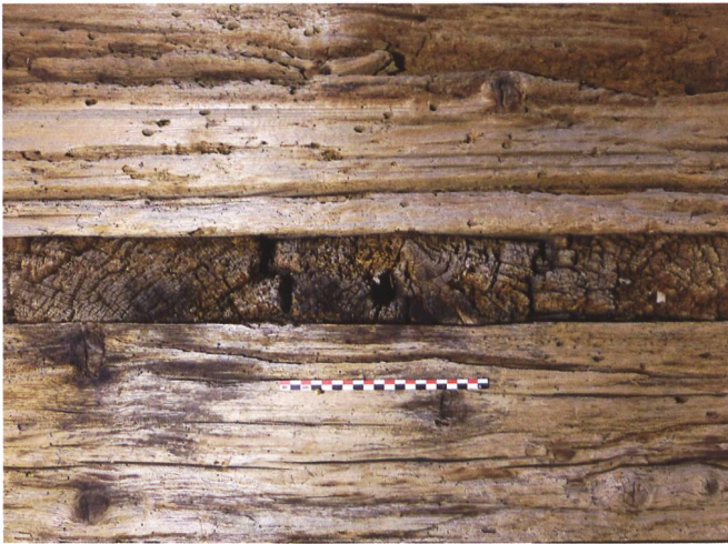
Abb. 6: Schwyz/Ibach, Oberschönenbuch 46. Südfassade, zweites Wohngeschoss. Wanddurchstossende Decken-/Bodenbohlen.
