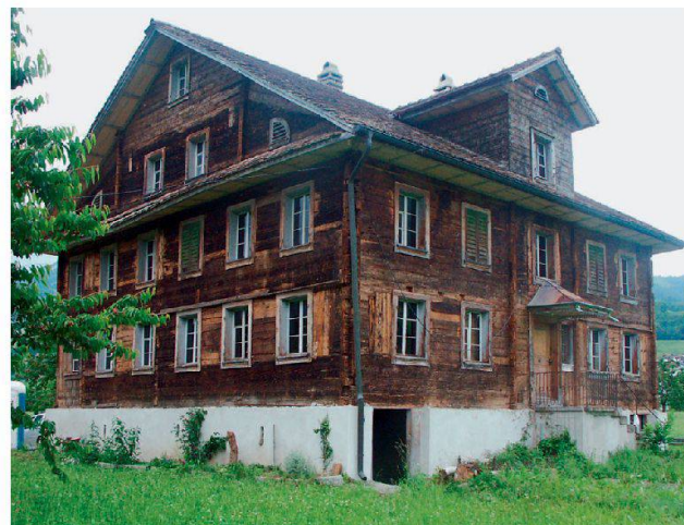
Abb. 2: Anwesen gegen Nordwesten: links vor Entfernen des Schindelschirmes (Aufnahme vom 11. März 2009) und rechts nach Entfernen des Schindelschirmes (Aufnahme vom 8. Juni 2009).
