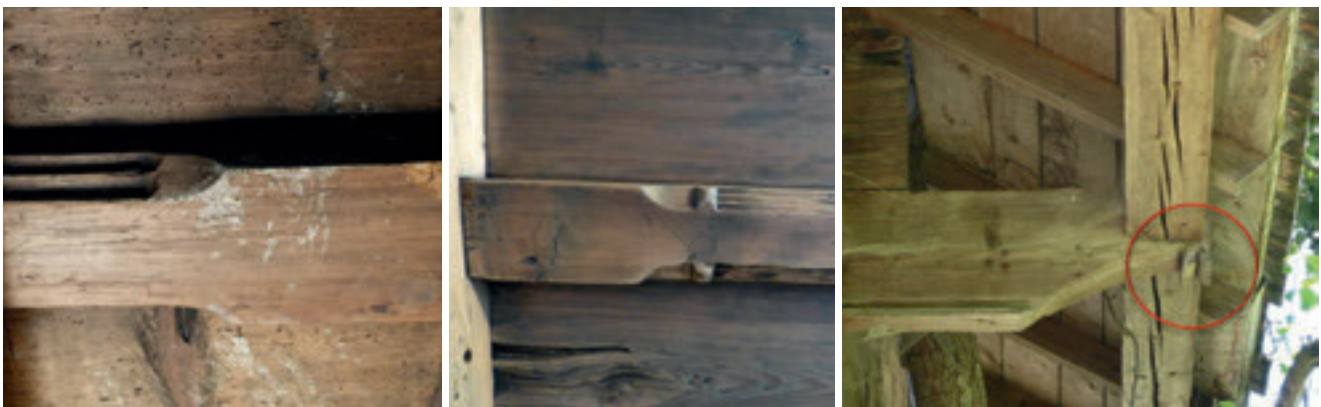
Abb. 9. Zierformen – Balkenkanten und -enden. Links: Flüelen UR, Axenstrasse 2 (1608d). Zweifache Kehlung mit Schmieg; Mitte: Erstfeld UR, Wasserschaft 19 (1739d). Dreifache Kehlung mit Wulst und Schmieg; rechts: Muotathal SZ, Aport 8 (1768i). «Roskopf». Fotos BAB Gollnick, U. Gollnick.
