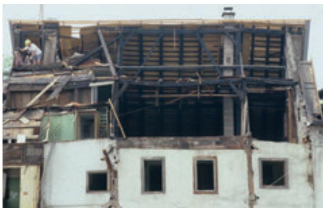
Abb. 17. Baar ZG, Rathausstrasse 6/8. Kernbau mit sekundär aufgesetztem, steilem Dach, während des Abbruchs. Ansicht von Osten. Foto ADA ZG, M. Bolli.
