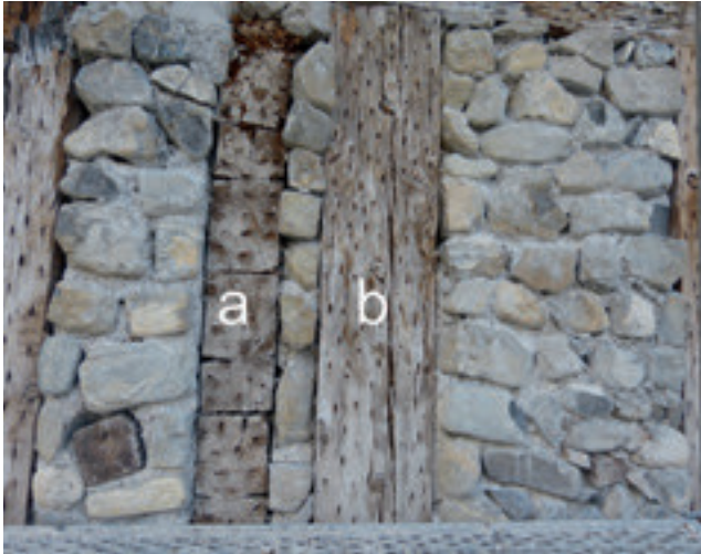
Abb. 14. Seewen SZ, Hirschenstrasse 13. Gesamtvorstoss des Blockbaus errichtet 1622d (a), mit Riegelwerk verblendet 1739d (b); die Löcher stammen von hölzernen Keilchen zum Befestigen des Verputzmörtels. Foto BAB Gollnick, U. Gollnick.
