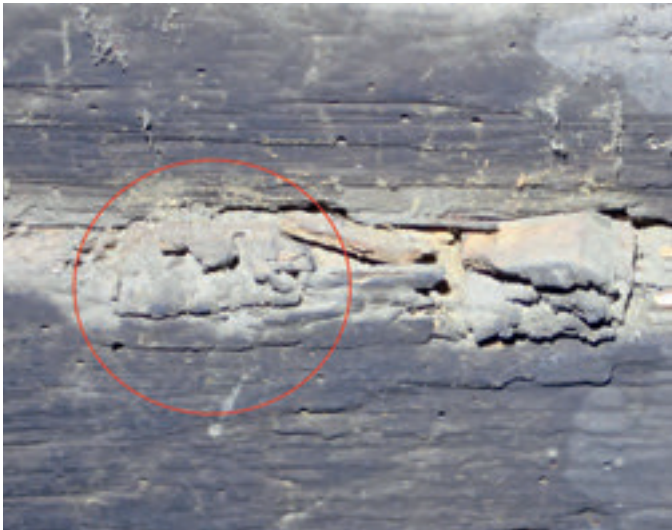
Abb. 4. Steinen SZ, Rübengasse 12 (1269d). So genannter Geisterbandndübel, links in Fundlage, rechts entnommen. Foto BAB Gollnick, U. Gollnick (links) und LRD, B. Yerly (rechts).
