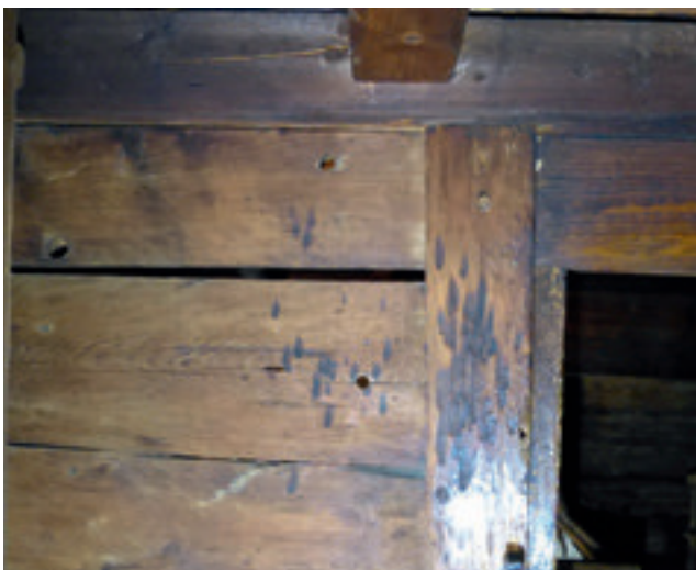
Abb. 5. Wildhaus SG. Geburtshaus Zwingli (1449d). Kammer im zweiten Vollgeschoss, Westwand. Flämmchenförmige Brandspuren auf Wand und Türpfosten. Foto BAB Gollnick, U. Gollnick.
